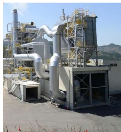
バイオマス発電所 真庭市撮影
