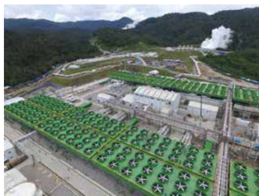
サルーラ地熱発電所第2号機
