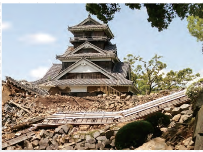
熊本地震被害の様子
