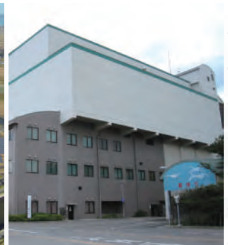
米子市クリーンセンター
