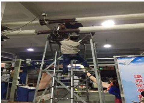
中国側の設備現場検査
