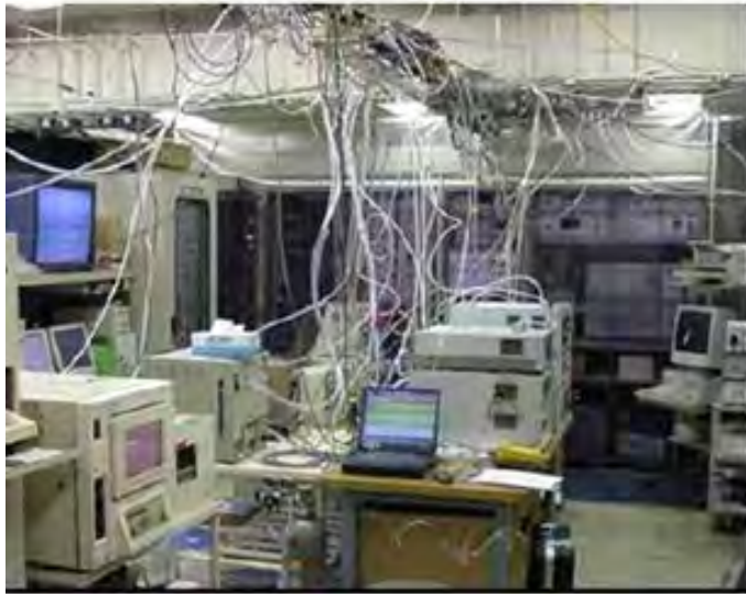
試験設置状況全景図
