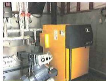
ボイラー本体
