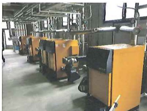
さくら診療所の乾燥チップボイラー（50kW×2）
