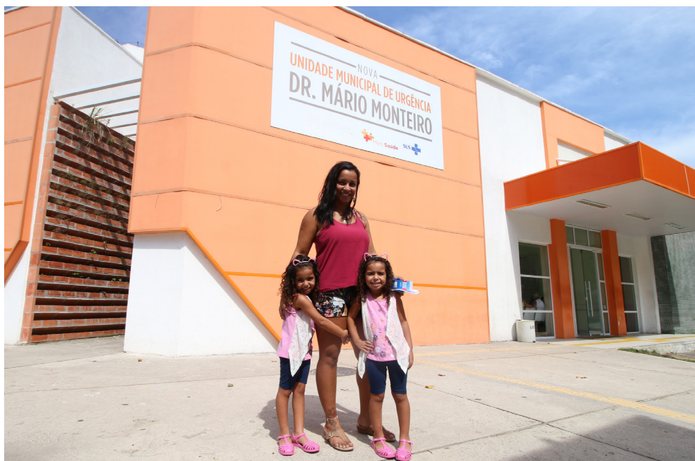
New Municipal Emergency Unit Dr. Mário Monteiro.
