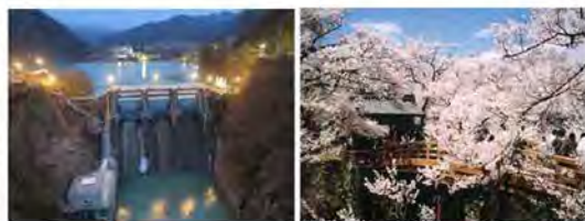
高遠さくら発電所(伊那市) (出力180kW 約350世帯分を発電)
