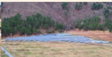
グリーンパーク都路発電所(449kW)
