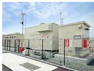
バイオディーゼル非常用発電機 (500kWh)
