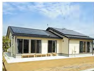
集会所 (防災拠点) ソーラー付 (PV9.1kW)
