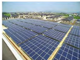
防災調整池ミドルソーラー
