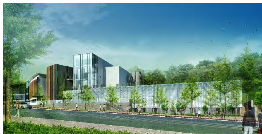
水熱源ヒートポンプにより、CO 2 発生量が半減(基本設計時)
