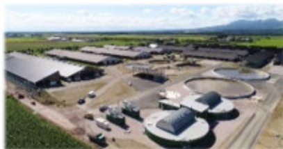
バイオガスプラント
