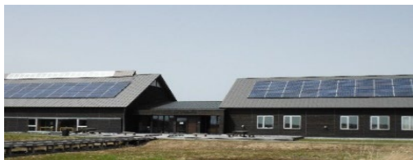
太陽光発電設備の設置
