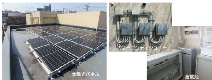
図11 第三者所有方式による太陽光パネルと蓄電池の導入例（日明市民センター）出所：北九州市
