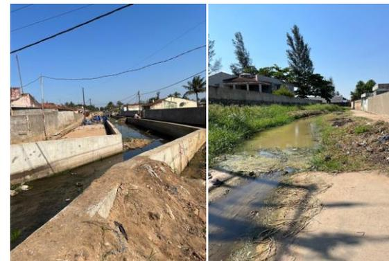
自力で排水網を整備しているが、不連続部分が多く、浸水が生じている。
