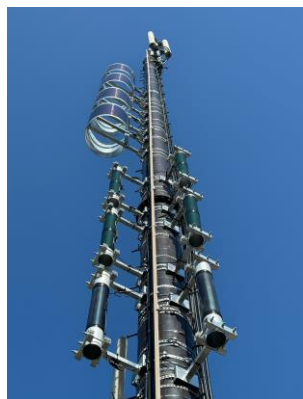
＜ポールに巻き付けたペロブスカイト型太陽電池＞
