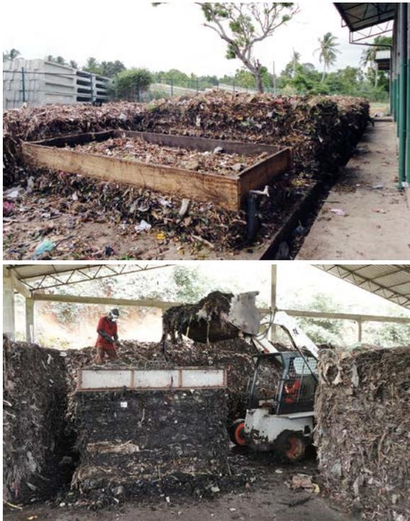
図35 木枠とスキッドステアローダーを使って堆肥化用原料を積み上げる様子 (Karunaratna, 2020)
