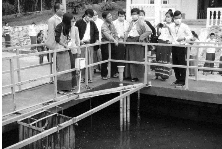
図10：ネピドーの中央廃水処理施設（出典：筆者、2016年）
