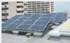
太陽光発電設備
