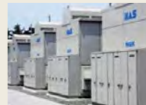
大容量蓄電池
