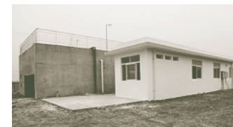
四川省徳陽市に建設した生活排水処理施設
