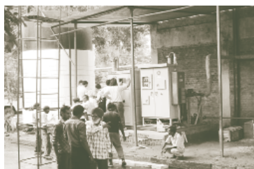
ミルク工場に設置された電気ヒートポンプ
