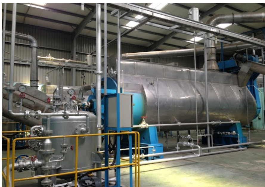
Hình 10. Hệ thống lò hơi tải nhiệt
