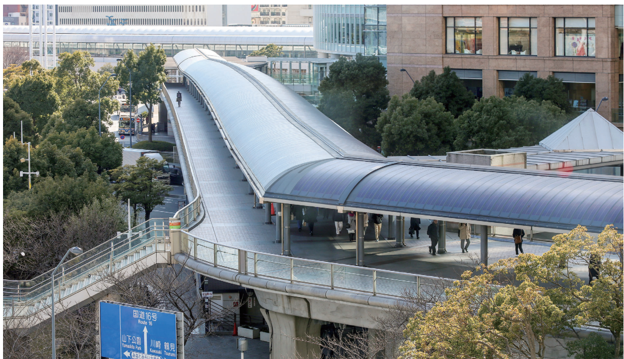
▲日本樱木町人行道屋顶上的太阳能电池板
