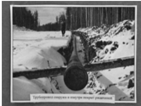
サハ共和国 (ヤクーツク) のタラカン・ビチム石油パイプライン建設 (今春) Oil pipeline Talakan-Vitim construction in Sakha-Yakutia.
