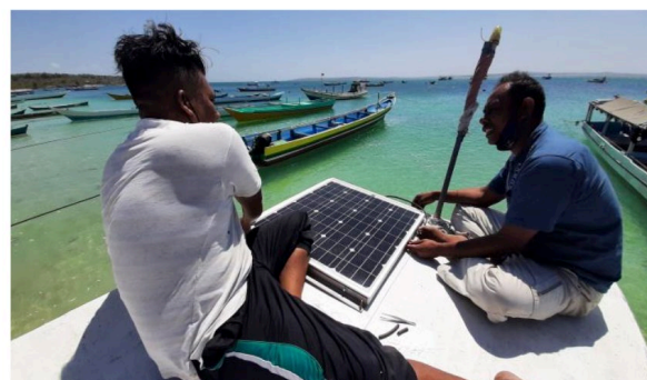
Gambar 2. Pemasangan PLTS
