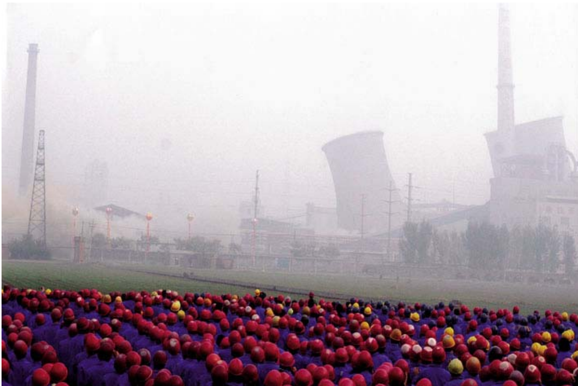
小規模発電ユニット爆破の瞬間
