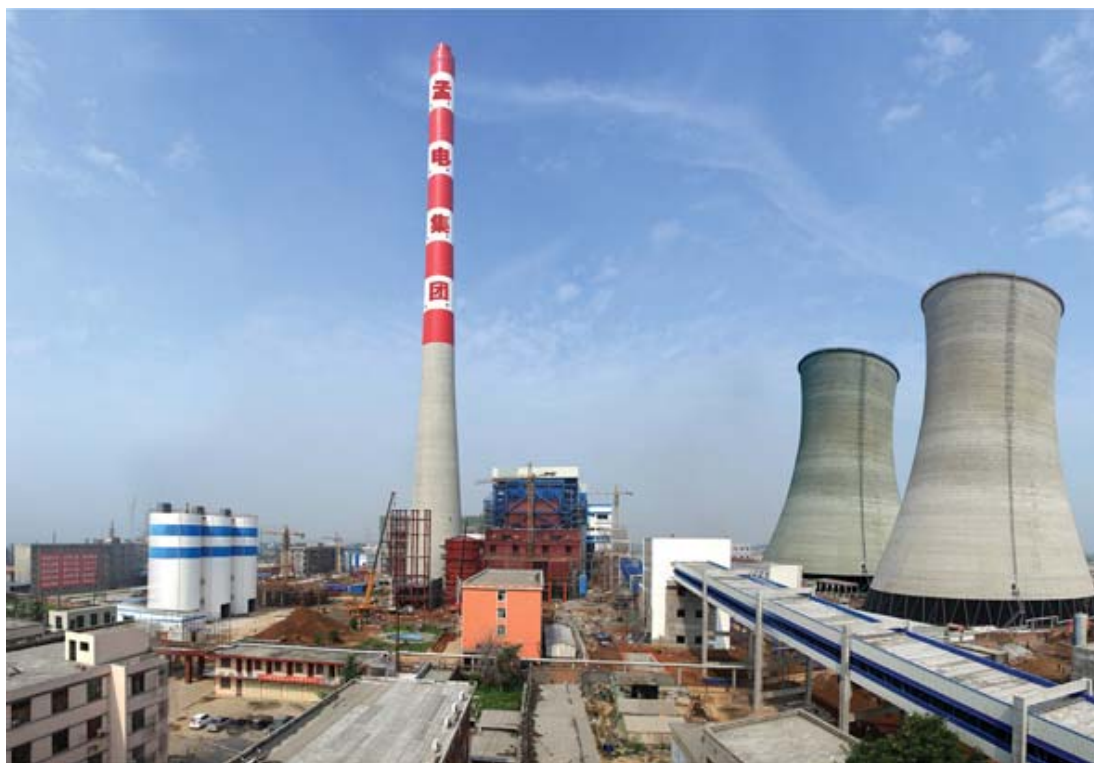
発電所の脱硫、湿式電気集塵改造プロジェクト
