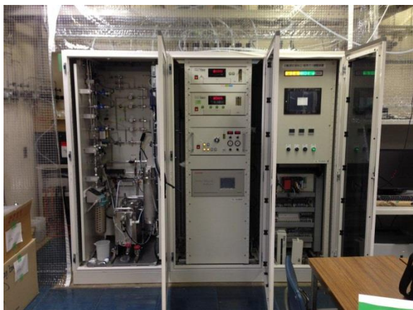
精製空気及び水分発生装置全体
