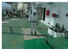
最后的涂装作业 (岸壁)
