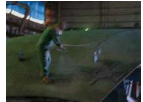
室内涂装作业
