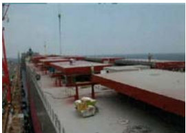
最后的涂装作业 (岸壁)
