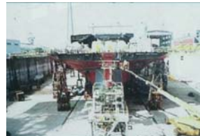
室外涂装作业 (船坞内)
