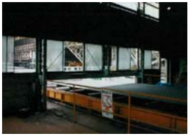
防锈涂装作业
