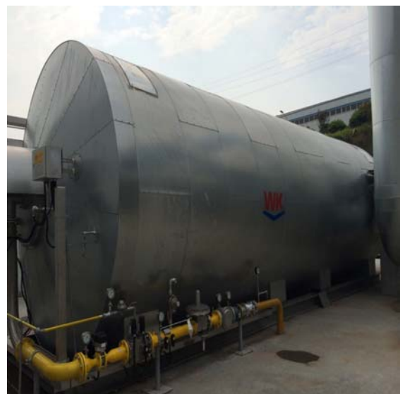
熱交換式燃焼脱臭システム（TNV）
