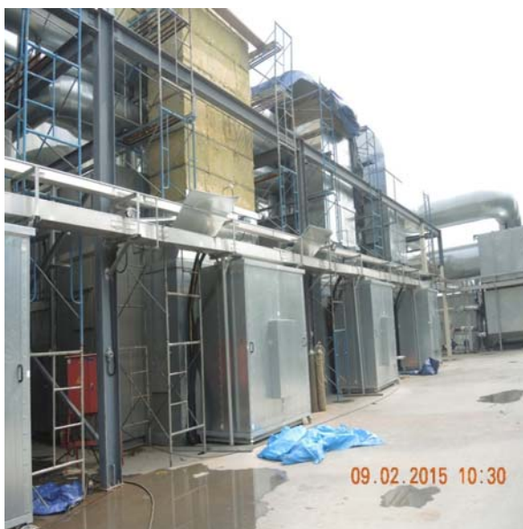
前処理装置と ゼオライトローター吸（脱）システム
